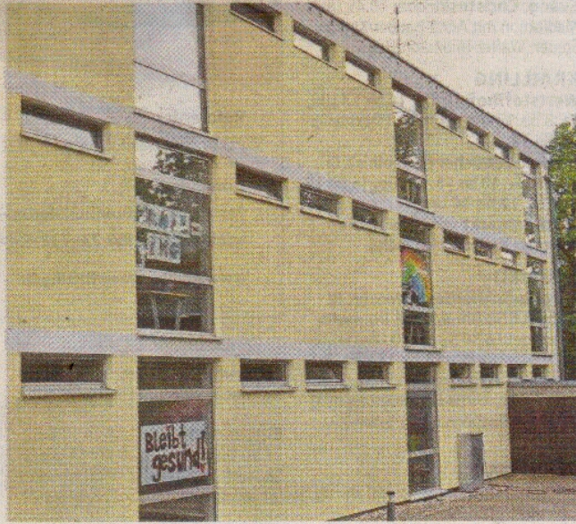
Die Krailinger Grundschule und die zugehörigen Gebäude stehen vor einer grundlegenden Neuordnung. A-FOTO: WOHLRAB
